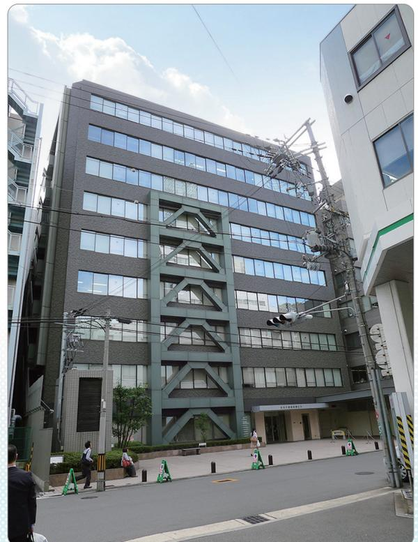
横堀ビルのファサード。工事計画では耐震ブレースから向かって左を第1工区、ブレース部分を第2工区、右を第3工区とし、2階から9階までを縦割りする形でゴンドラを吊って作業した
