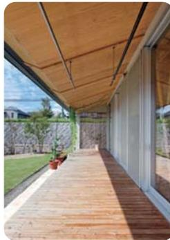
日射遮蔽型エコガラスの窓が並び、2階吹抜けスペース。逆勾配の庇は目に入らず、さえぎるものもない青空をのぞむことができる
