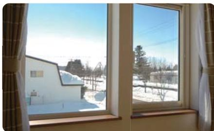
引き違い窓を使わないことで気密性を高めたエコガラスの窓。窓台を見ると、二重の断熱材と空気層がある壁の厚みもよくわかる
