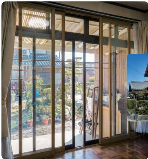
リビングの掃き出し窓には4枚引きの内窓を設置。自由に動き、拭き掃除もしやすい。窓枠は開めた際に外窓の枠とぴったり重なるので視覚的にもうるさくない
