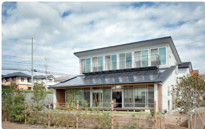
太陽を独り占めするように南向きの窓が並ぶY邸。1階屋根は太陽光発電パネルの効率を、2階屋根は窓からよりも多くの光を得られるように考えて、それぞれ角度が決められた
